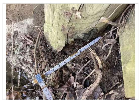
Bent #1 pile B decay
